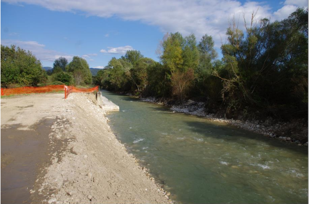
Visione del Sangro durante i lavori (settembre 2016). Si nota come in sponda sinistra sia stata rimossa la difesa in cemento che restringeva l'alveo del fiume e ancora presente in fondo
