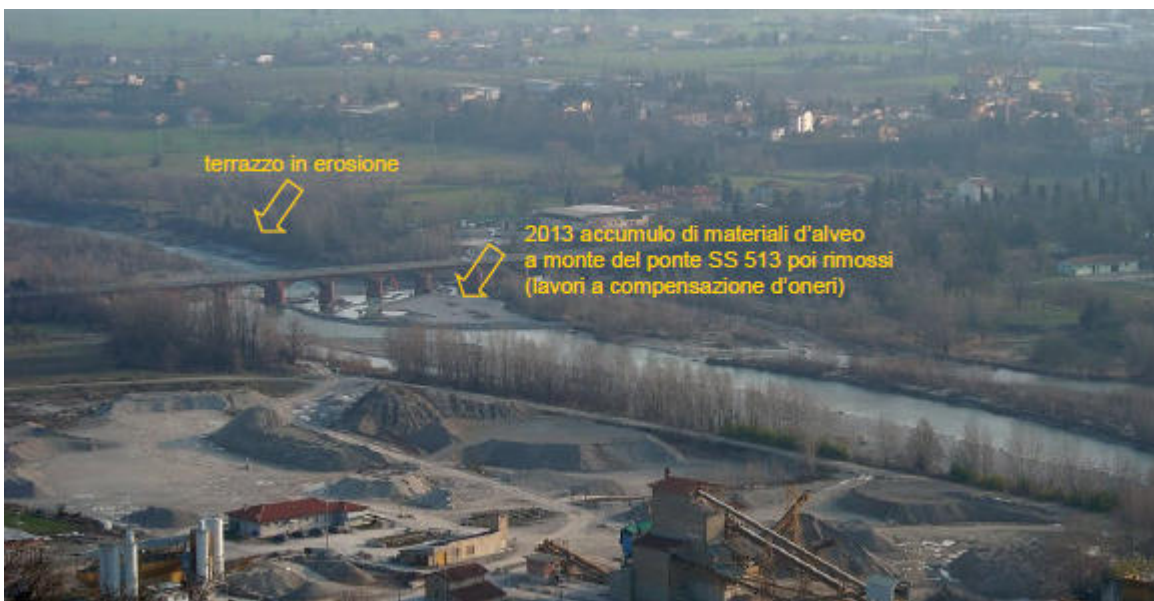
La situazione a monte e a valle del ponte
