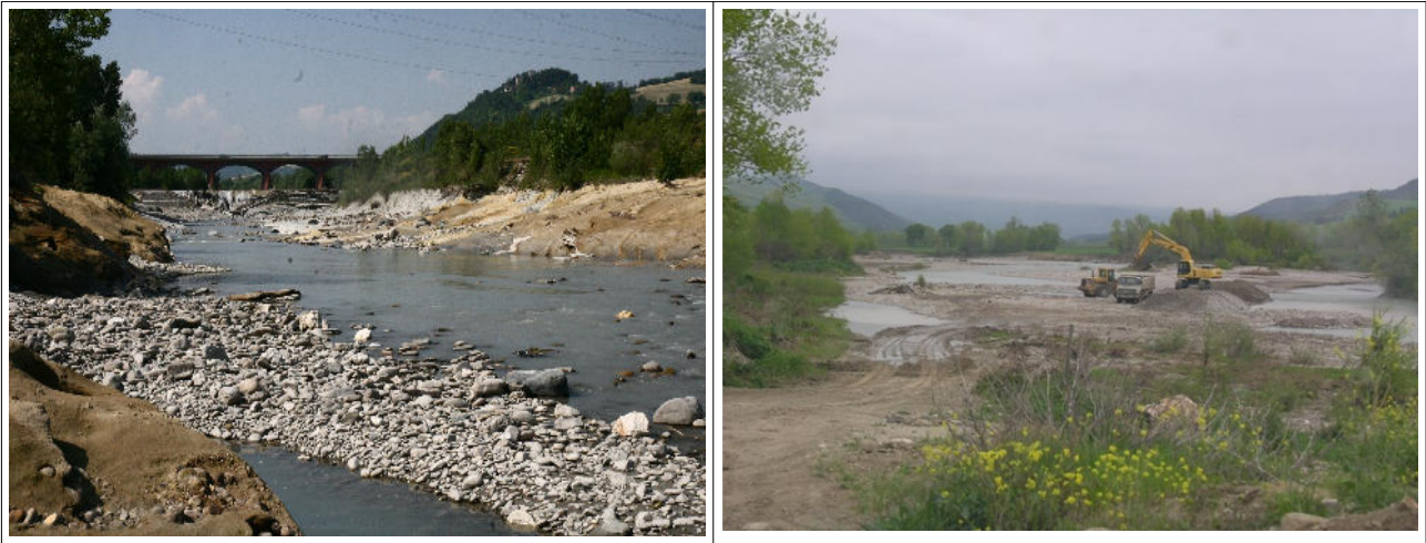
L'incisione dell'alveo con emersione delle argille pleistoceniche e l'escavazione poco a monte
