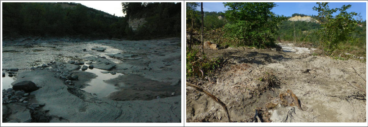
La postazione “Lagheti di Savena” prima e dopo l'intervento
