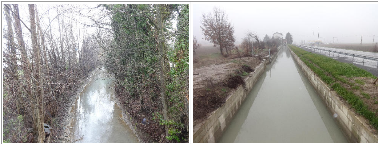
Il rio Comune in un tratto privo di interventi e nel tratto oggetto di “sistemazione”.
