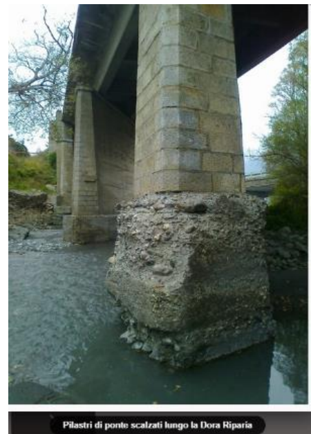
Fig. 76. Basamenti di pilastri esposti sulla Dora Riparia
