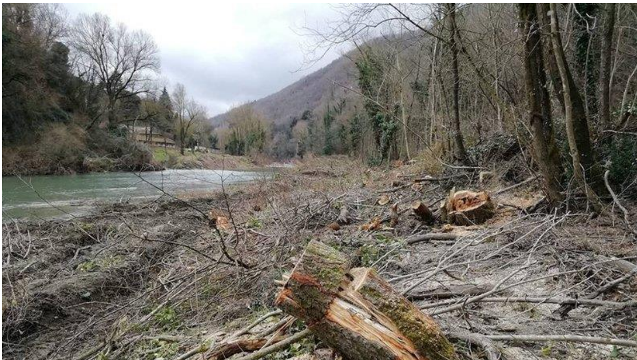
Fig.15. Fiume Santerno 10.4.2019 Taglio di alberature, con mezzi meccanici e a mano per cippato nel tratto montano del fiume Santerno, sotto il ponte Alidosi di Castel del Rio Appennino tosco-romagnolo 16
