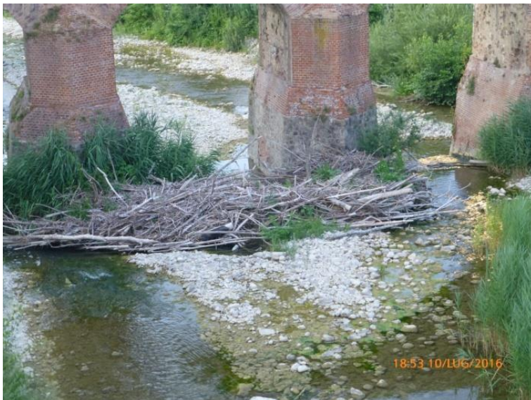
Fig. 18. 10.7. 2016 piloni del Ponte di Pianoro Vecchio
