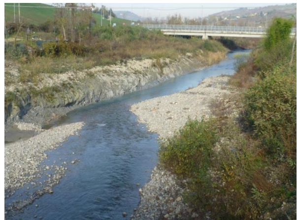
Fig.23. 30.11.2015; erosioni di sponda e incisione dell'alveo del Savena (dalla Passerella della Boaria); sullo sfondo il Ponte della Boaria (BO) i cui piloni potrebbero essere soggetti agli stessi gravissimi problemi che hanno interessato il P.te di V. Serrabella
