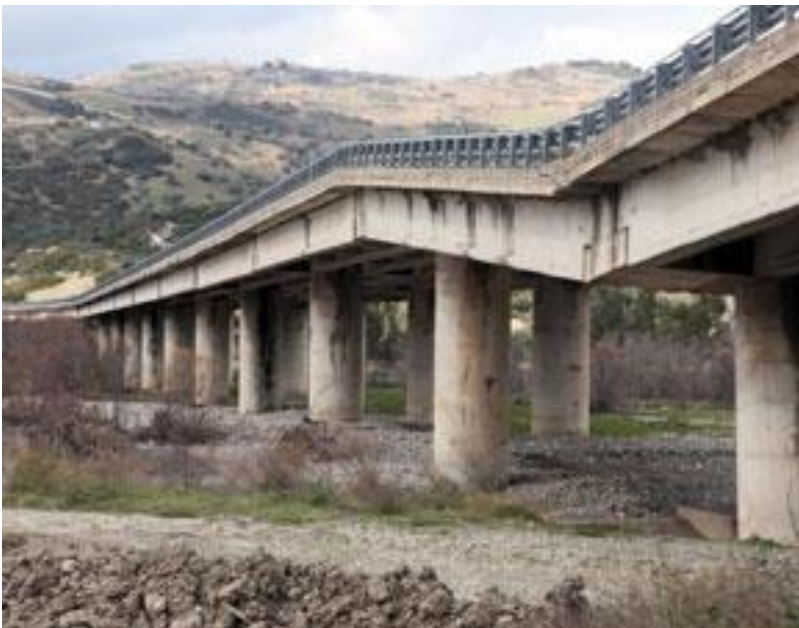
Fig.75. Ponte sul Basento
