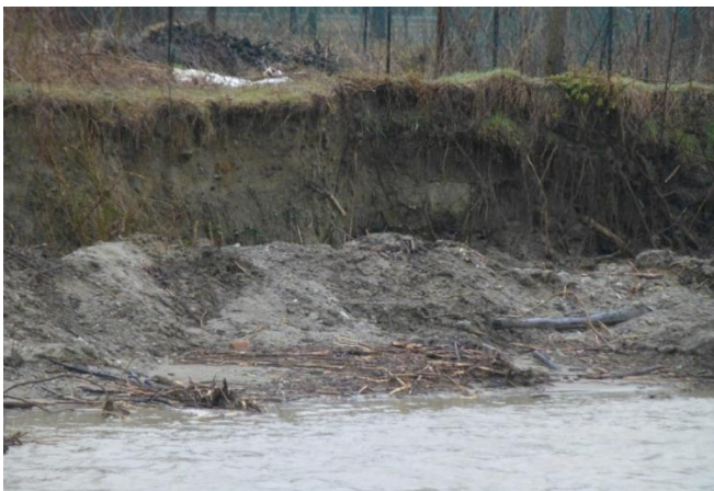
Fig.22. 22.2. 2015; erosioni in sponda sinistra poco a monte di Pianoro Vecchio (BO); qui era presente il bosco ripariale abbattuto pochi mesi prima. Le radici "all'aria" dimostrano che l'erosione è stata recente, probabilmente avvenuta in occasione dell'evento di piena.
