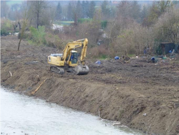
Fig. 31 Savena, Pian di Macina, Pianoro (BO), "rimodellamento" delle sponde, 17 dic. 2014.
