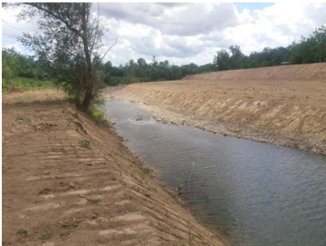
Fig.67. Torrente Arbia (2018) Lavori di taglio raso della vegetazione riparia
