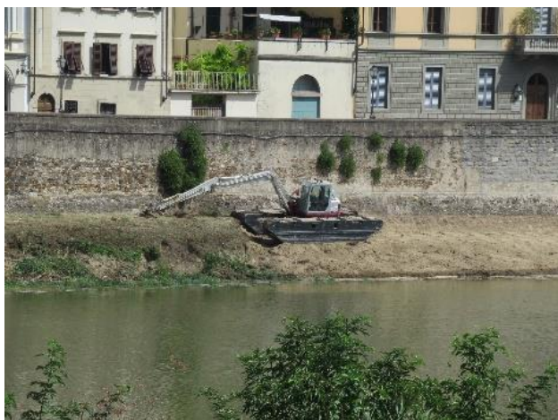
Figg. 61 e 62. Fiume Arno (FI) 22.10.2019. Taglio e rimozione sedimenti fluviali e vegetazione a cura del Consorzio di Bonifica 3 Medio Valdarno. Utilizzo di escavatore anfibio a valle di Ponte Vecchio fino alla Pescaia di Santa Rosa
