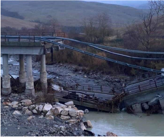
Figg.77 e 78. Cedimenti recenti: sulla sinistra ponte sul fiume Paglia (2.3.2020) e sulla destra sul Magra in località Albiano lungo la Sp70 (8.4.2020) Solo mancanza di manutenzione o anche l'abbassamento dell'alveo ha contribuito a rendere instabile l'intera struttura?
