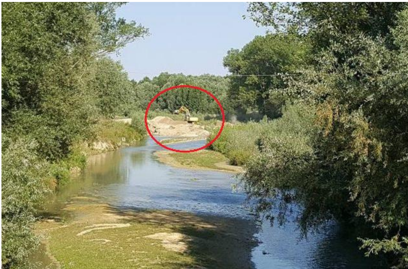
Fig. 43. Fiume Musone. Osimo (AN) (2.4.2020) Abbattimento della vegetazione arborea, completa trinciatura della vegetazione arbustiva, la rimozione del materiale litoide e l'ingresso in alveo con macchinari molto ingombranti per lavori di manutenzione eseguiti lungo la confluenza del fiume Musone e il torrente Fiumicello nella zona di Osimo, effettuati da fine dicembre a fine gennaio di quest'anno. Associazione La Confluenza. 22 Un escavatore in alveo e le ottime linee guida che però non vengono seguite dagli operatori sul campo che continuano con interventi contrari a quanto contenuto nelle linee guida stesse.
