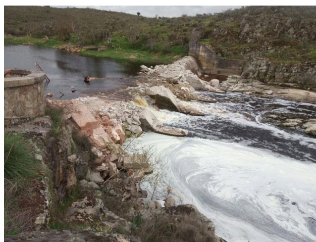
Fig. 35 e 36 La diga prima e dopo la rimozione 21
