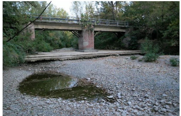
Figg.20 e 21 Ponte su via Pedagna con soglia e pozza relitta
