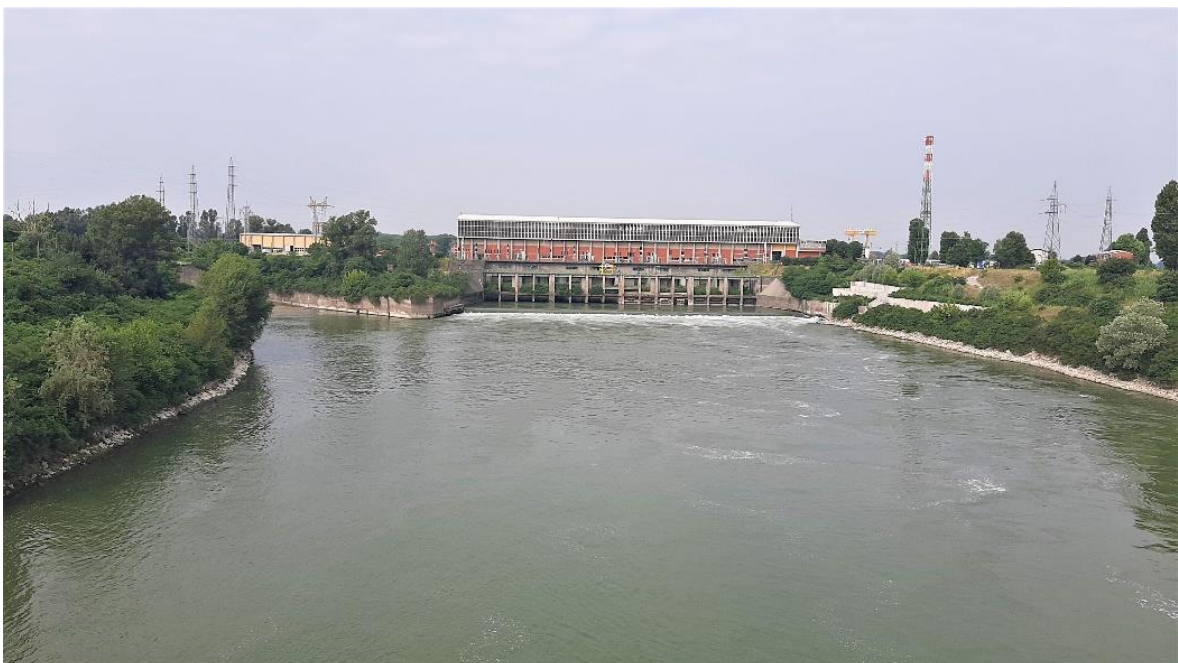
Fig.6 Centrale idroelettrica di Isola Serafini sul Po (Pc)
