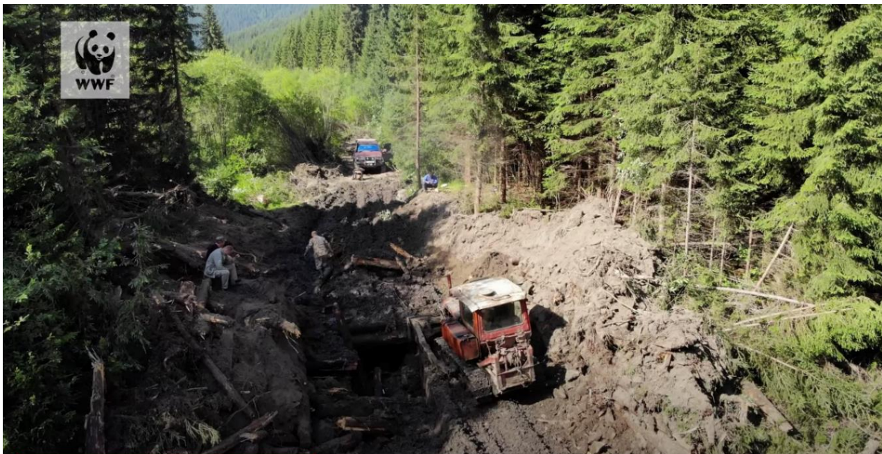
Fig. 31 La diga di Lostunets è stata una delle 3 dighe rimosse in Ucraina (2020). Il WWF-Ucraina, sostenuto dal WWF-Paesi Bassi, ha lanciato il progetto di rimozione delle dighe a caduta durante l'estate 2020 per rimuovere queste dighe lungo i torrenti e i fiumi del bacino del fiume Cheremosh (Parco Nazionale Verkhovynskiy e oltre) situato nella regione di Ivano-Frankivsk, vicino al confine statale ucraino-rumeno.
